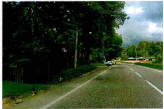
VISTA GENERAL ÁREA REQUERIDA - EN SENTIDO GIRARDOT - BOGOTA
