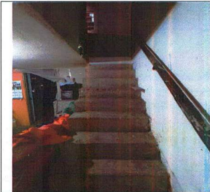
Descripción Vista de escalera de C1, sótano
