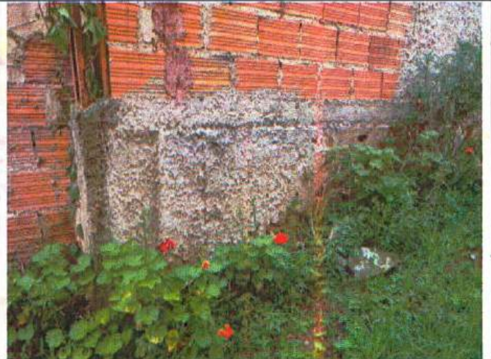
Descripción Vista de cimentación de C1
