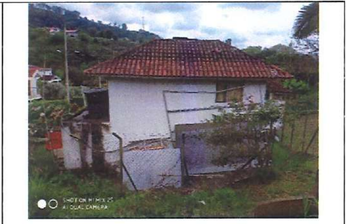
C1: Vista posterior de la construcción
