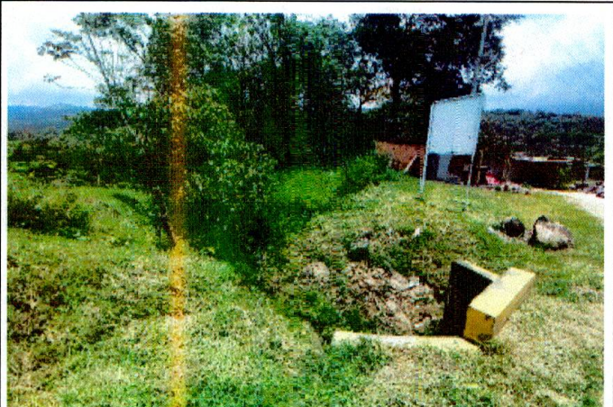
VISTA DEL CUERPO HIDRICO Y LA OBRA ACTUAL DE DESCOLE.
