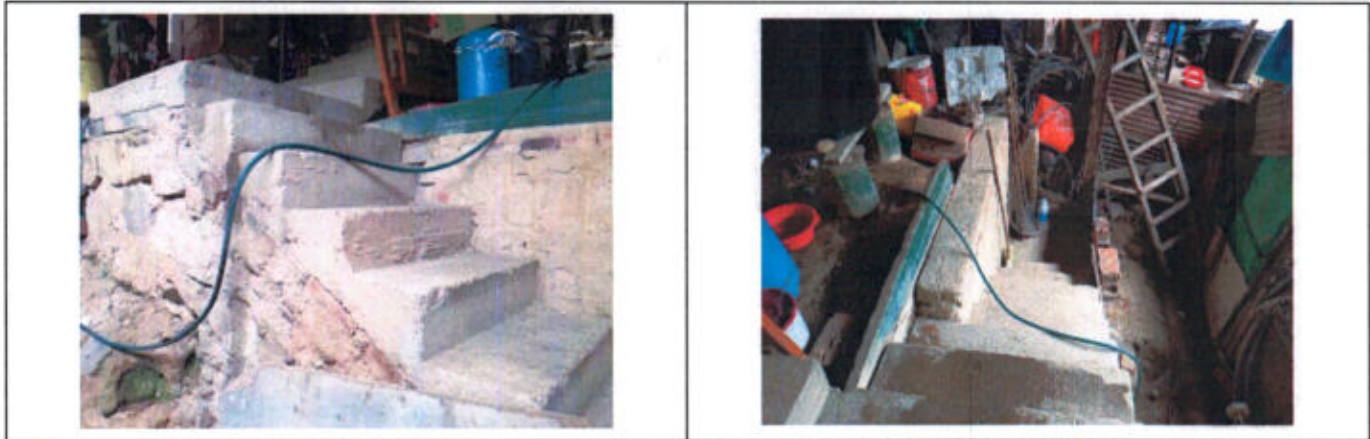
M2 – ENRAMADA PATIO - ESCALERA
