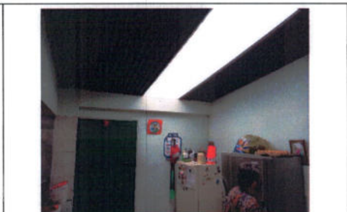
C1 – VIVIENDA – PUERTA ACCESO PATIO
