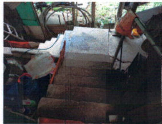
M2 – ENRAMADA PATIO - ESCALERA
