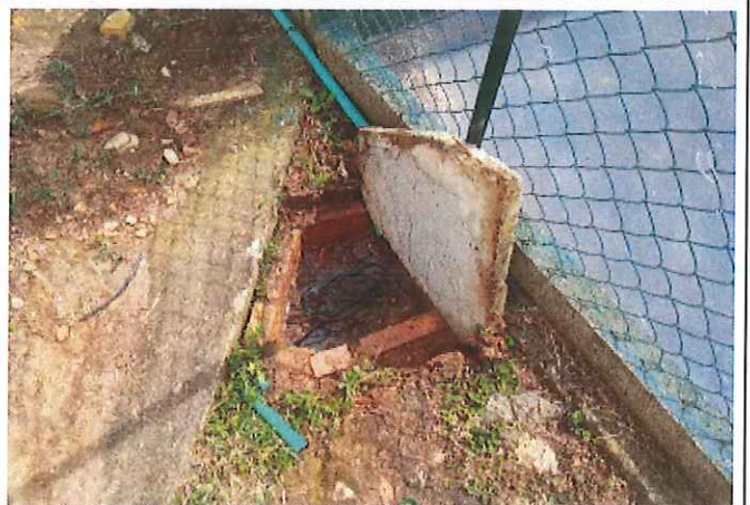
M4 – CAJA DE INSPECCION
