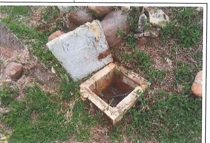
M1 – CAJA DE INSPECCION
