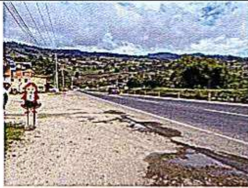
Vista del Sector
