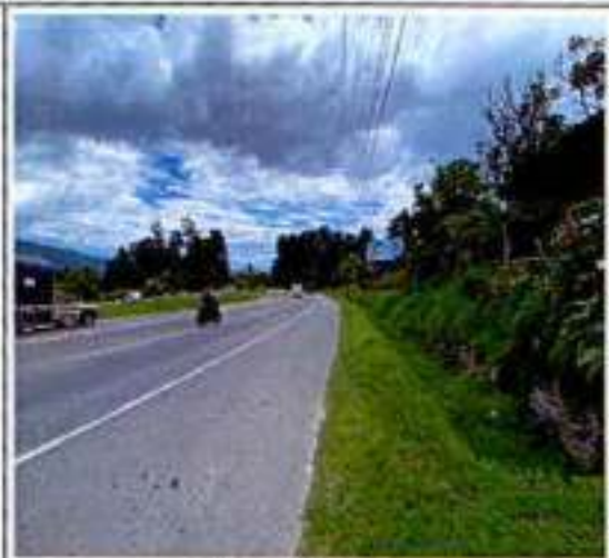
Vista del Sector
