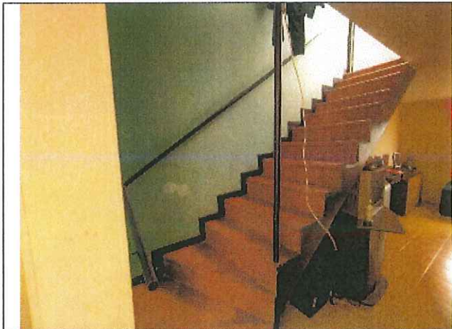
Descripción Vista de escaleras a terraza
