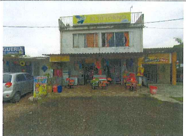
Descripción - Vista del área requerida del predio y de C1 construcción.
