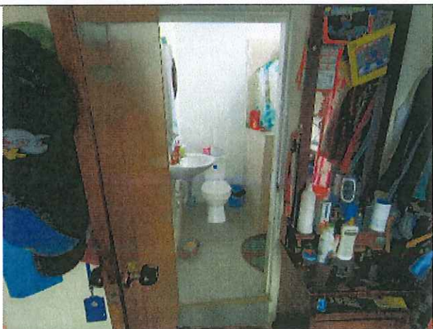
Descripción Vista de baño piso 2
