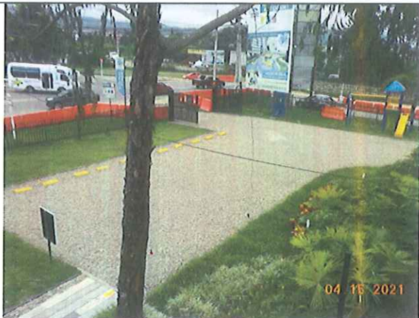
M11: Adecuación de terreno (Parqueadero).
