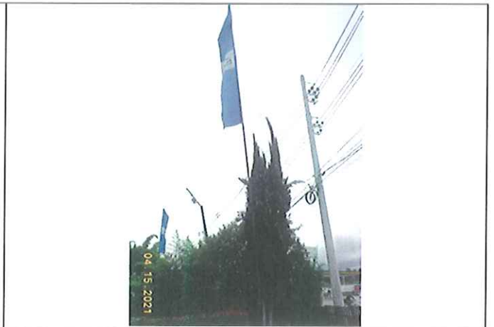
Poste de localización.
