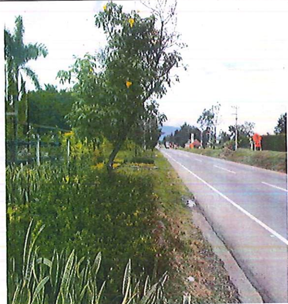
Descripción Vista del área requerida
