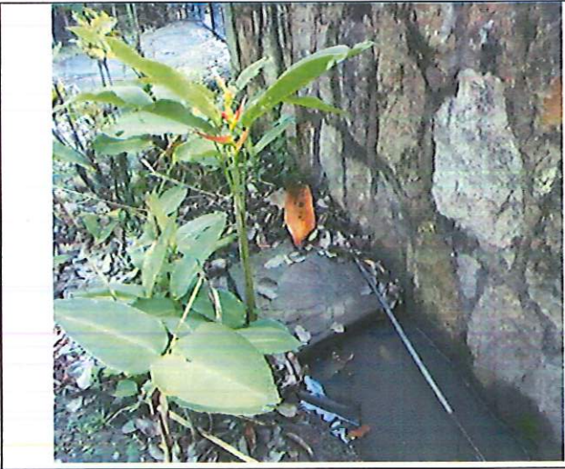
Descripción Vista de M8 caja de desagüe
