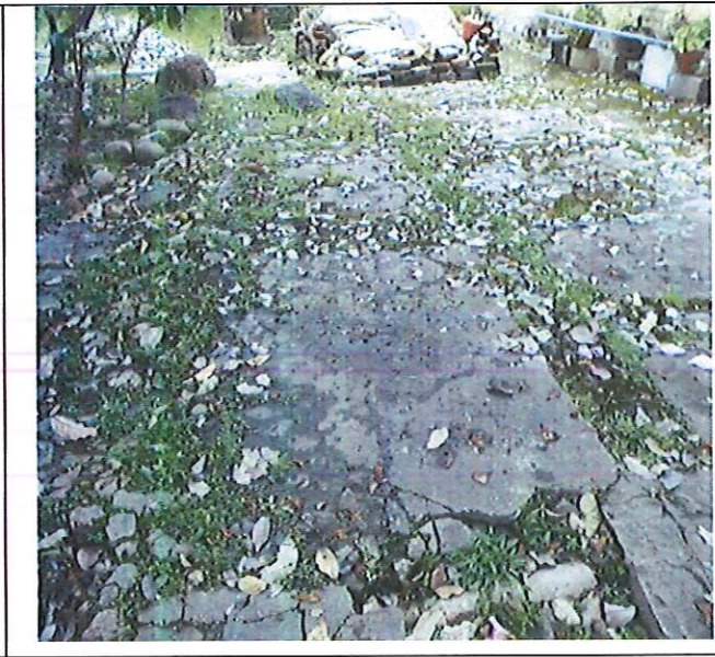
Descripción Vista de M10 placa de concreto
