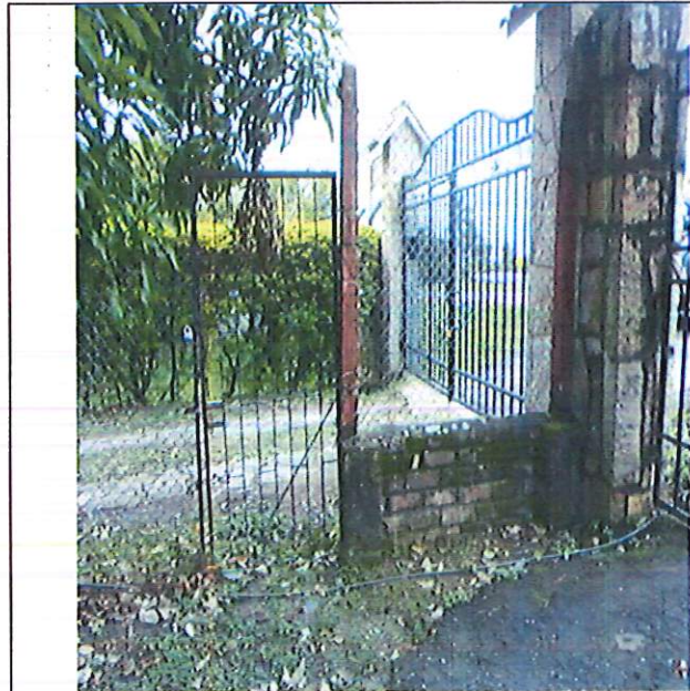
Descripción Vista de M3 cerramiento lateral
