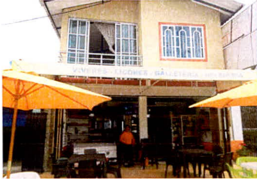
VISTA DE C1 EN EL ÁREA REQUERIDA
