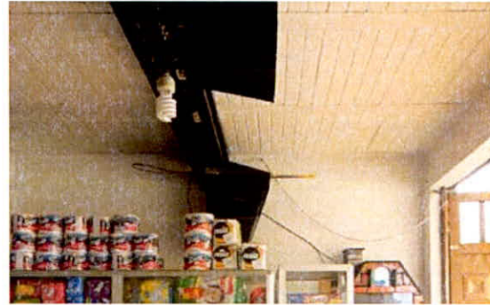
CUBIERTA DE C1
