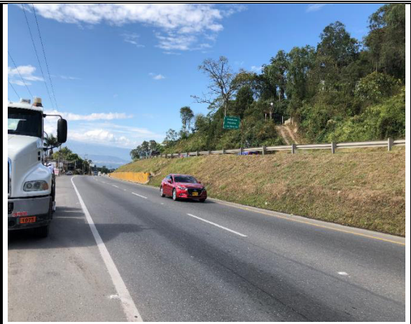
Vista del Sector.
