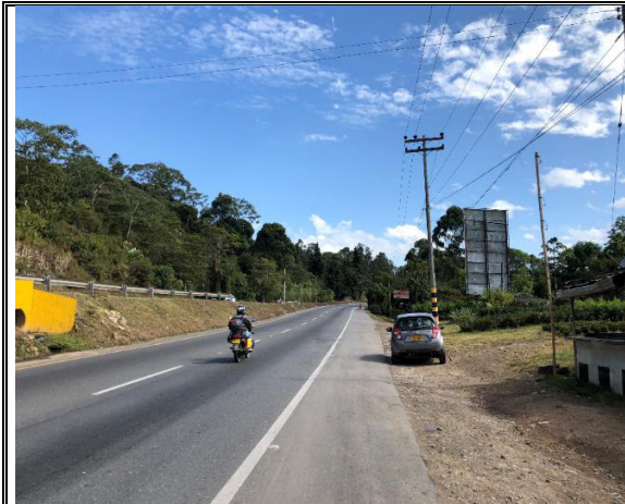
Vista del Sector.
