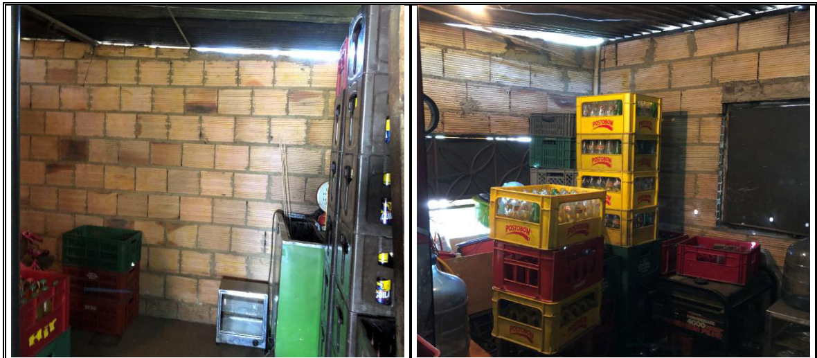
C1: Vista Interior de la Bodega
