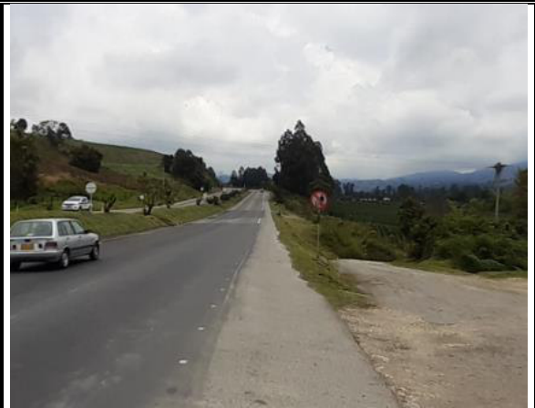
Vista del Sector
